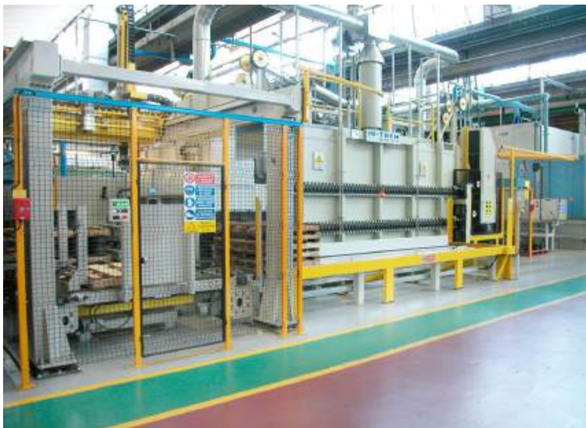
La parte finale e la pallettizzazione nella nuova linea di tempra e produzione rulli, nello stabilimento italiano di produzione componenti per mezzi cingolati.
