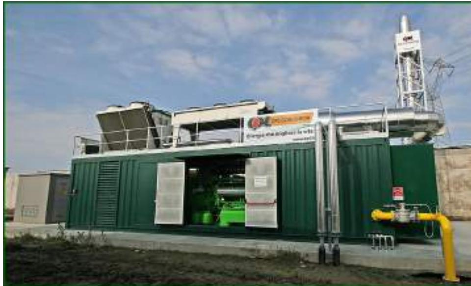
*Uno dei 4 motori Jenbacher, collocato in un apposito container appositamente ingegnerizzato per l'alloggiamento di tutti i componenti di processo necessari alla efficiente gestione del sistema.*
