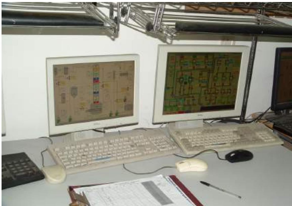
*Particolare della Sala Controllo dell'impianto di Biodiesel. Tramite le stazioni di supervisione Movicon ridondate, gli operatori controllano l'intero processo.*
