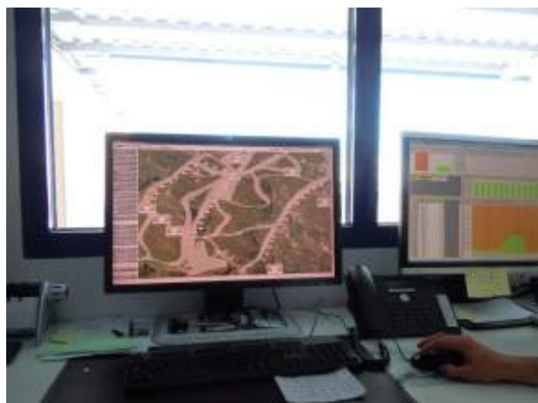
Nelle varie stazioni dell'impianto, gli operatori dispongono PC di supervisione in cui, attraverso la mappatura del comprensorio, gestiscono completamente ogni funzionalità dell'intero sistema
