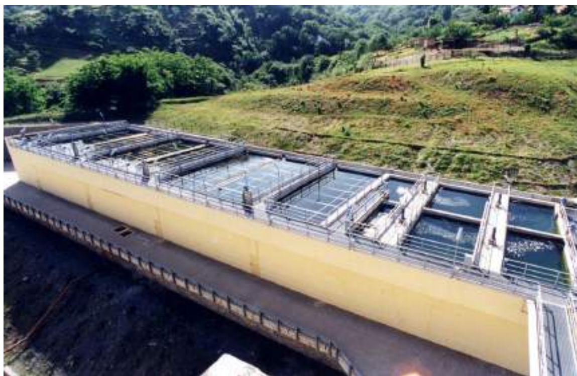
Particolare di una delle vasche di raccolta destinate al trattamento delle acque.
