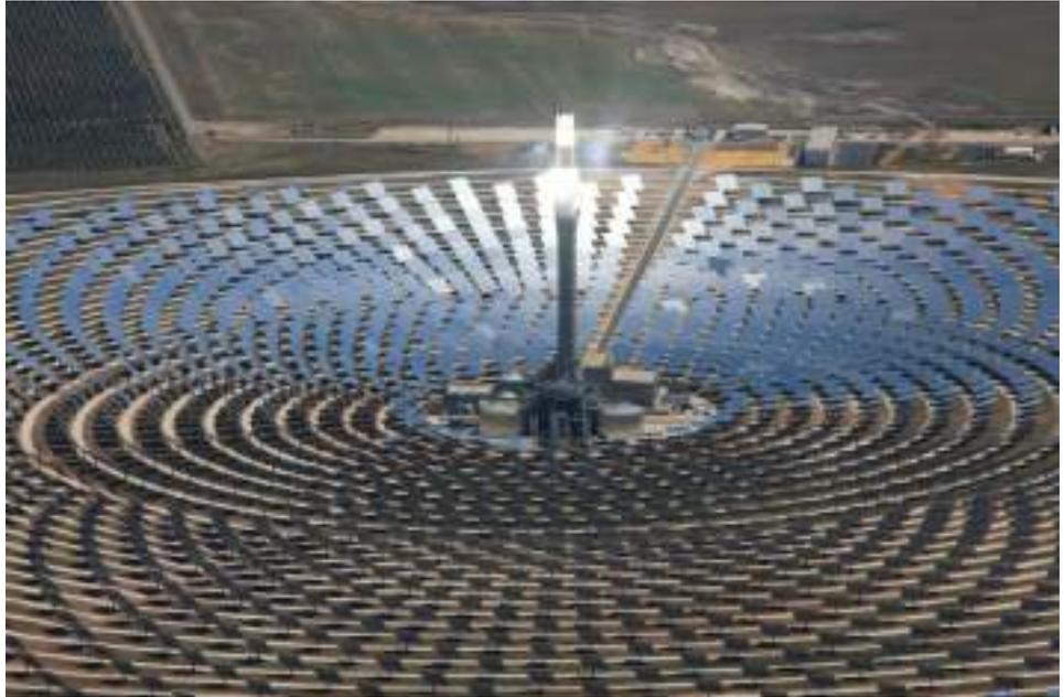
*2650 specchi concentrano ed inviano il calore del sole al ricettore sulla torre, alta 140 mt. Su una superficie complessiva pari a circa 260 campi da calcio. Questo innovativo impianto di produzione energia da fonte rinnovabile è in grado di produrre 400MWh al giorno.*
